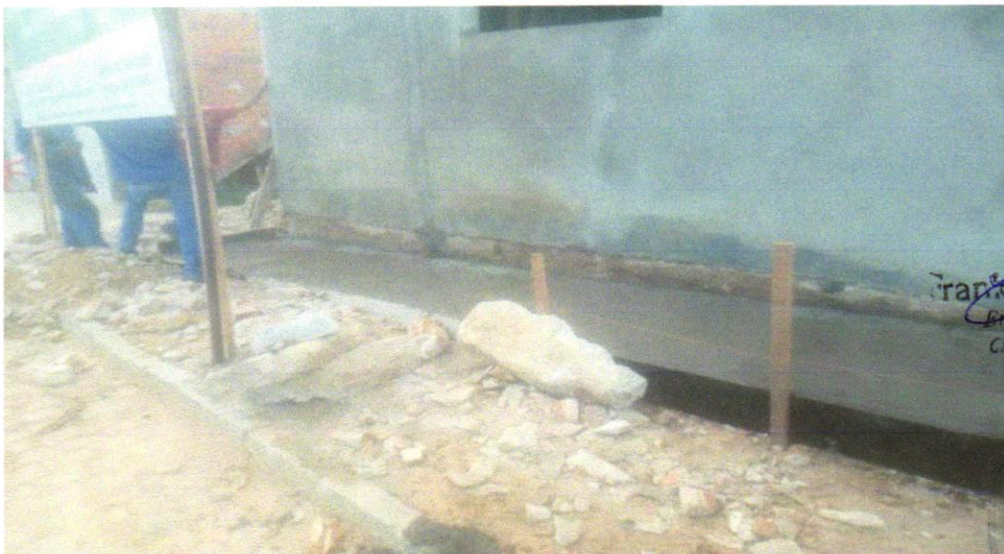
FOTO 22 – EXECUÇÃO DE PASSEIO (CALÇADA) OU PISO DE CONCRETO COM CONCRETO MOLDADO IN LOCO, FEITO EM OBRA, ACABAMENTO CONVENCIONAL, ESPESSURA 8 CM, ARMADO. AF_07/2016
