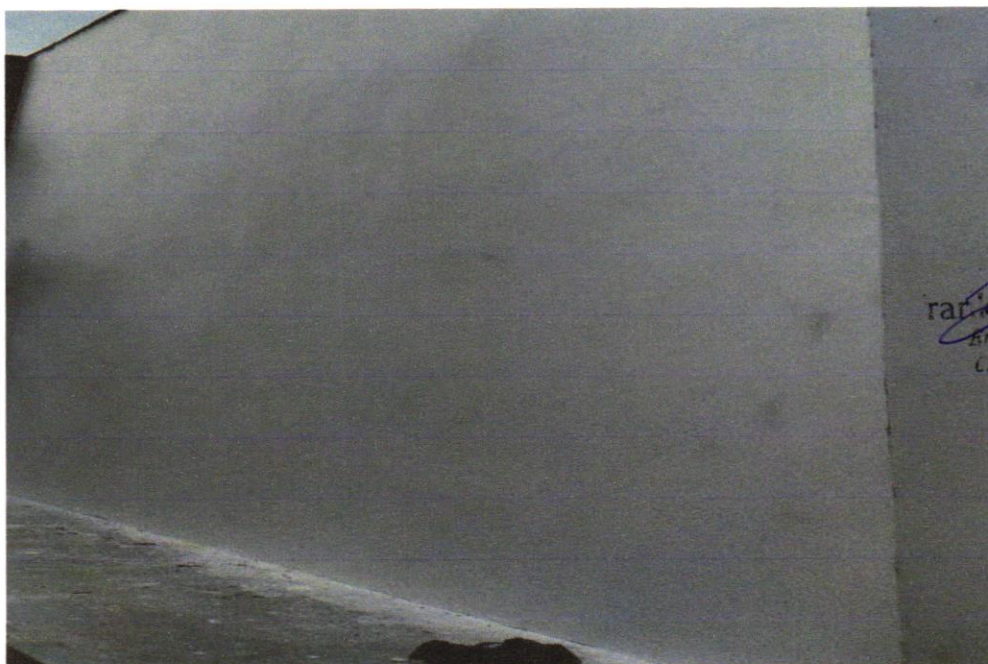
FOTO 6 – APLICAÇÃO E LIXAMENTO DE MASSA LÁTEX EM PAREDES, UMA DEMÃO, AF_06/2014
