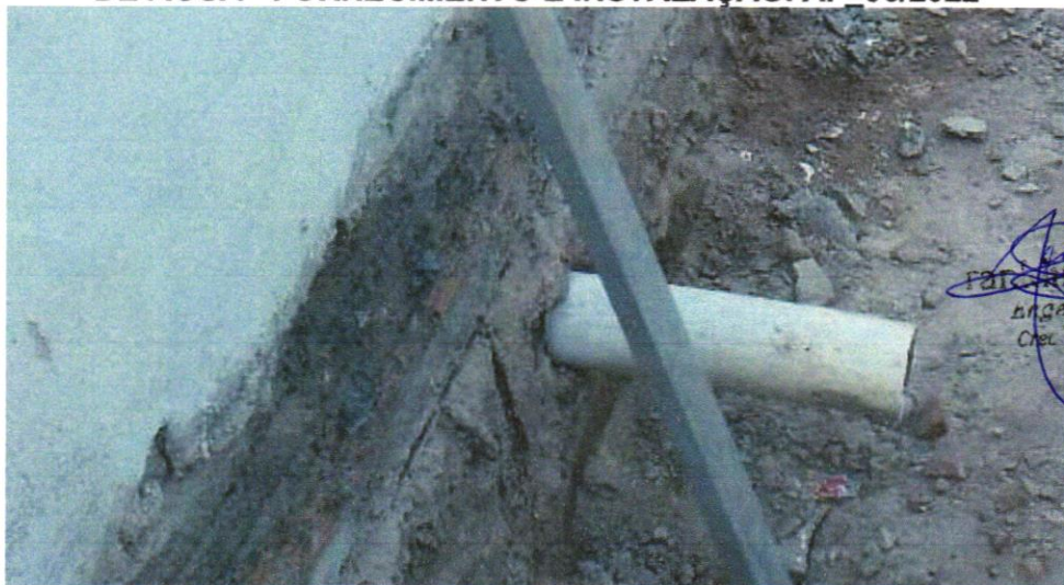
FOTO 26 - TUBO DE PVC BRANCO PARA REDE COLETORA DE ESGOTO CONDOMINIAL DE PAREDE MACIÇA, DN 100 MM, JUNTA ELÁSTICA - FORNECIMENTO E ASSENTAMENTO. AF_01/2021
