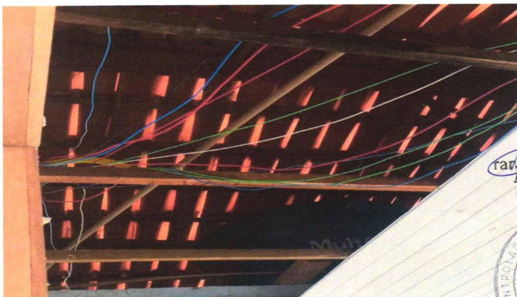
FOTO 20 – CABO DE COBRE FLEXÍVEL ISOLADO
