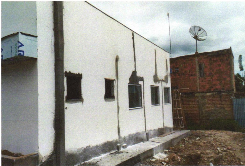
FOTO 05 – EXECUÇÃO DE PASSEIO (CALÇADA) OU PISO DE CONCRETO COM CONCRETO MOLDADO IN LOCO, FEITO EM OBRA, ACABAMENTO CONVENCIONAL, ESPESSURA 8CM, ARMADO AF_07/2016
