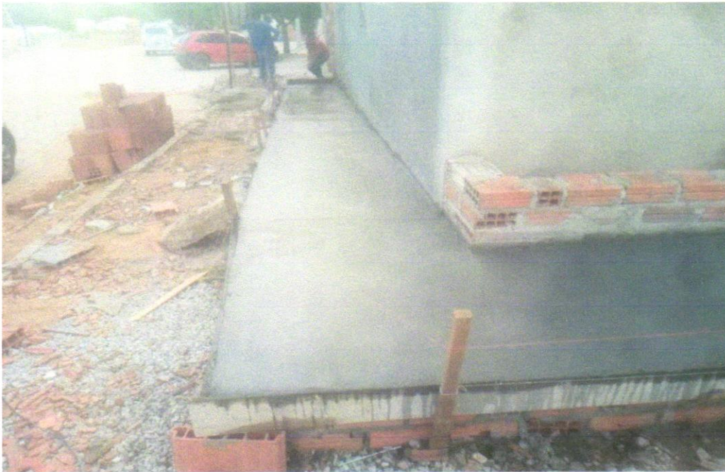
FOTO 21 – EXECUÇÃO DE PASSEIO (CALÇADA) OU PISO DE CONCRETO COM CONCRETO MOLDADO IN LOCO, FEITO EM OBRA, ACABAMENTO CONVENCIONAL, ESPESSURA 8 CM, ARMADO. AF_07/2016
