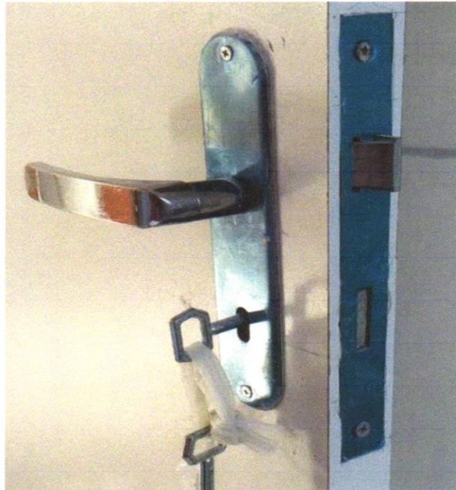
Foto 41 - FECHADURA DE EMBUTIR PARA PORTA DE BANHEIRO, COMPLETA, ACABAMENTO PADRÃO MÉDIO, INCLUSO EXECUÇÃO DE FURO - FORNECIMENTO E INSTALAÇÃO. AF_12/2019
