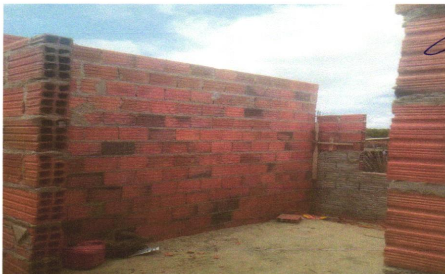
Foto 42 - ALVENARIA DE VEDAÇÃO DE BLOCOS CERÂMICOS FURADOS NA HORIZONTAL DE 9X19X29 CM (ESPESSURA 9 CM) E ARGAMASSA DE ASSENTAMENTO COM PREPARO EM BETONEIRA. AF_12/2021
